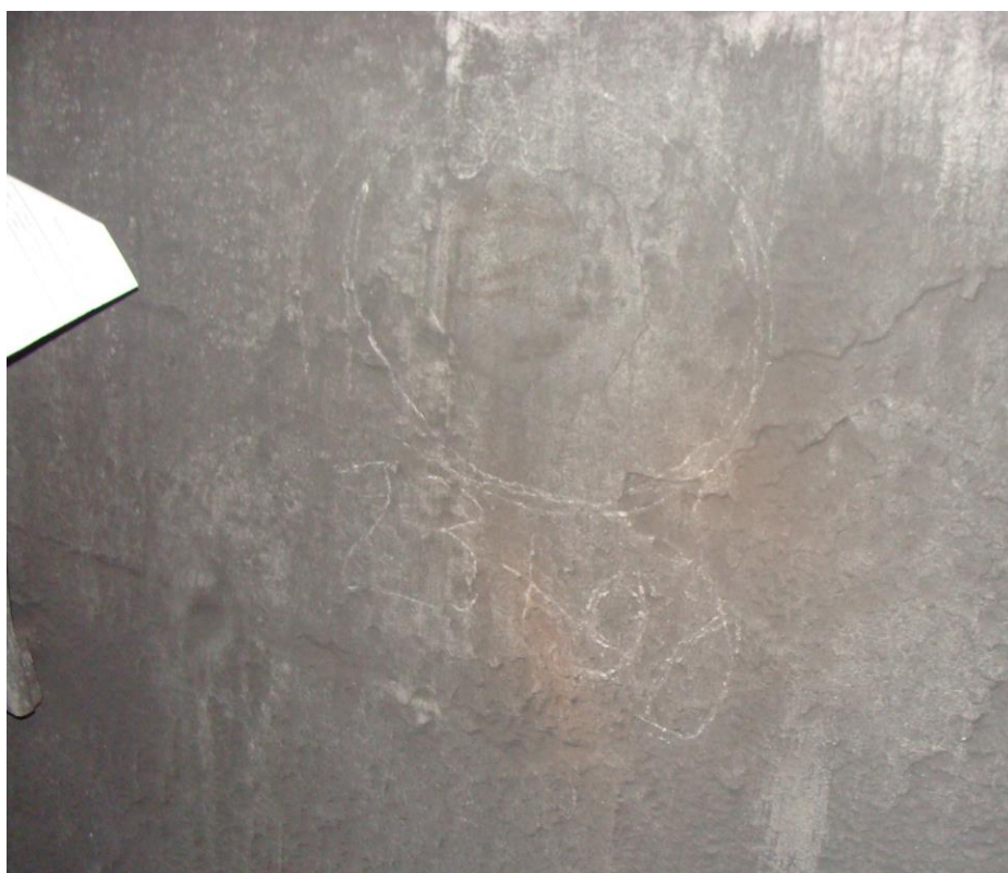
Рис. 2.6 Место испытания покрытия КАЛЬМАТРОН на прочность и водонепроницаемость в марте 2003 г. (фото от 15.11.2007 г).
